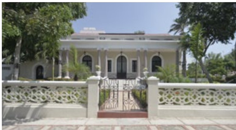
Edificio de la CRA.
