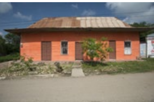
Casas con muros de bahareque o madera y cubiertas de zinc en Colosó y San Jacinto.
