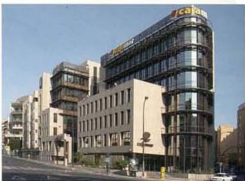
143 [B5] Sede central de la Caja Rural • Plaza de Barcelona, 5 • 1992-1996 • Arquitectos: Javier Arroyo González, Antonio Belmar Hernández, Jesús Martínez Durbán y Pedro Nau Yagüe
