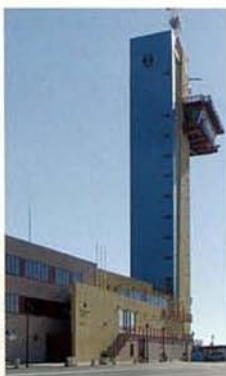
Torre de Control.
