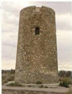
Torre del Perdigal.
