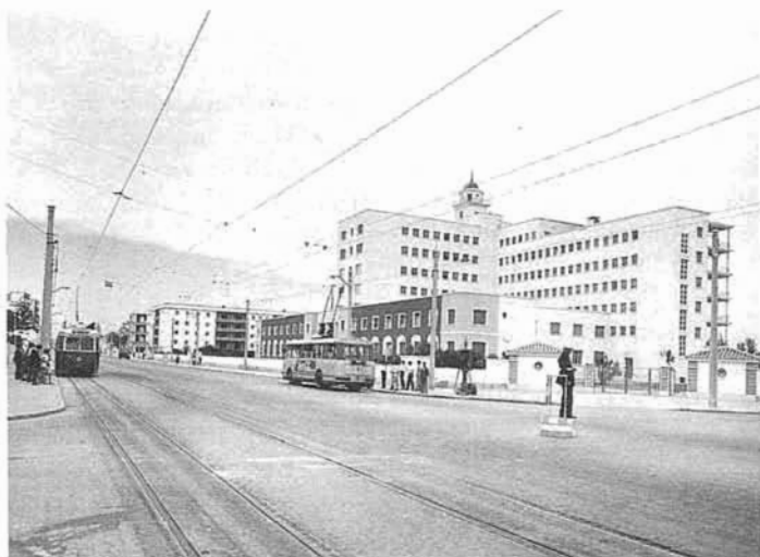
LA RESIDENCIA SANITARIA EDIFICADA EN LOS 50 Y DEMOLIDA EN LOS 70.
