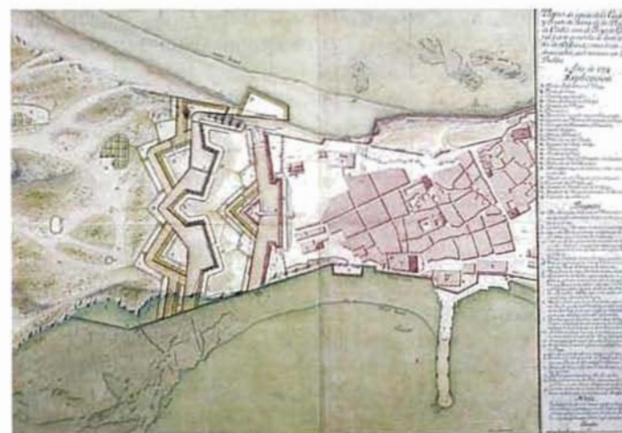
SEMIBALUARTE DE PUERTA DE TIERRA. 1724. [9]
