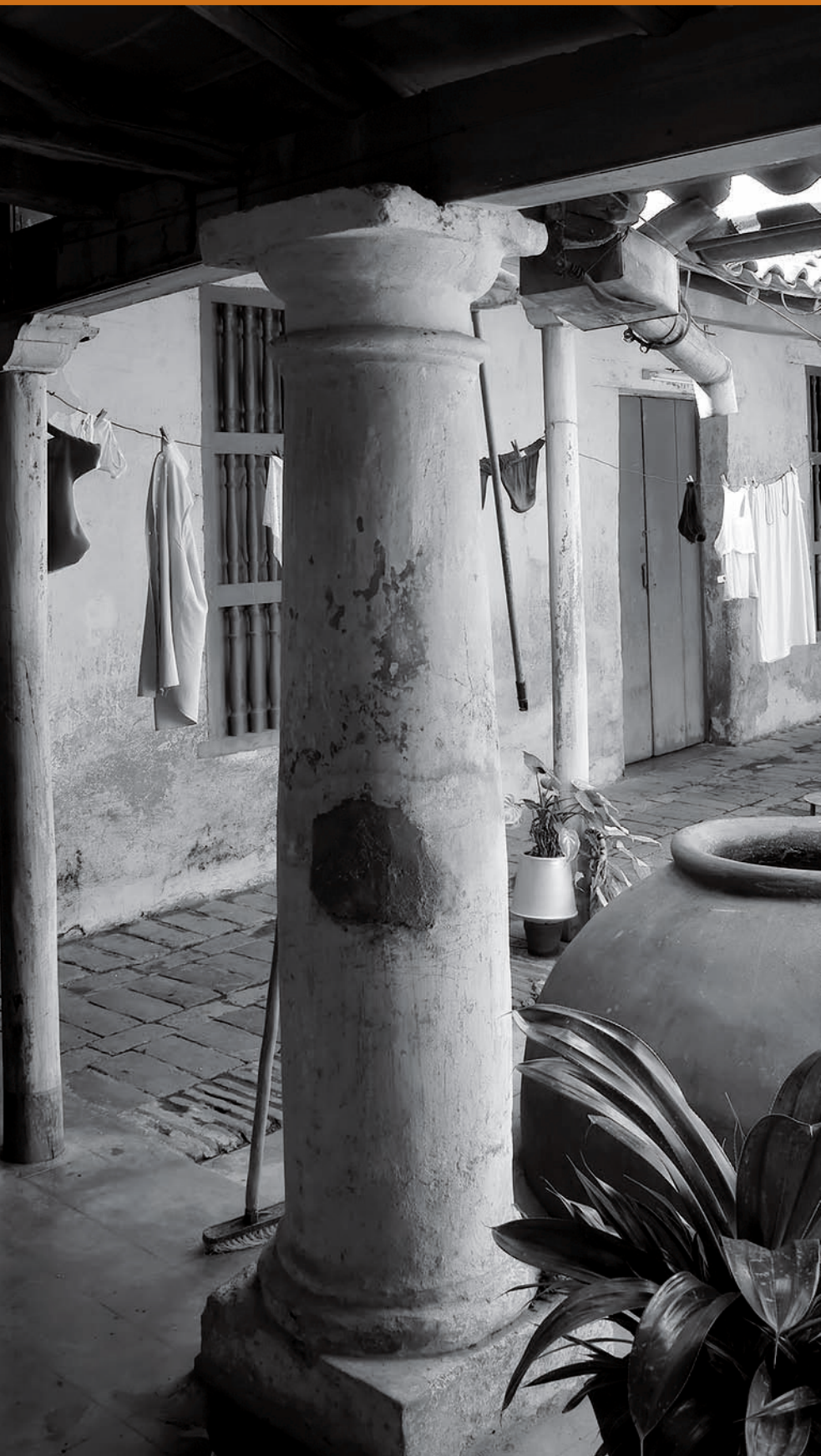
Casa en la Plaza de San Juan de Dios 5. House in the St John of God's Square.
