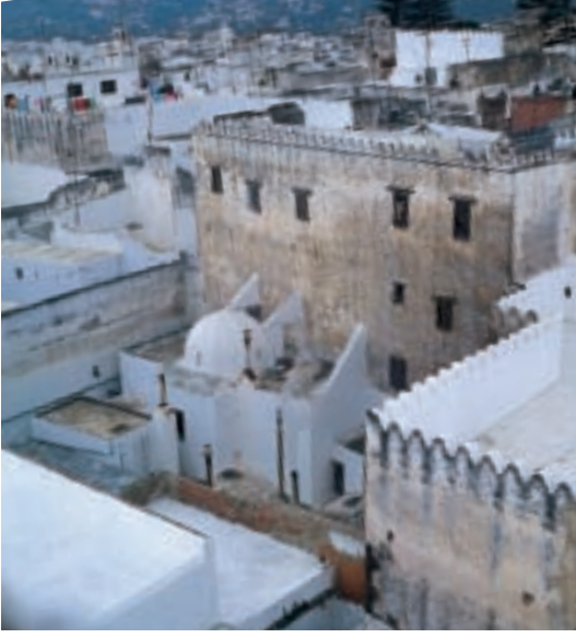
79. صورة لحمام سيدي المنظري من الخارج. Exterior del baño público al-Mandri.
