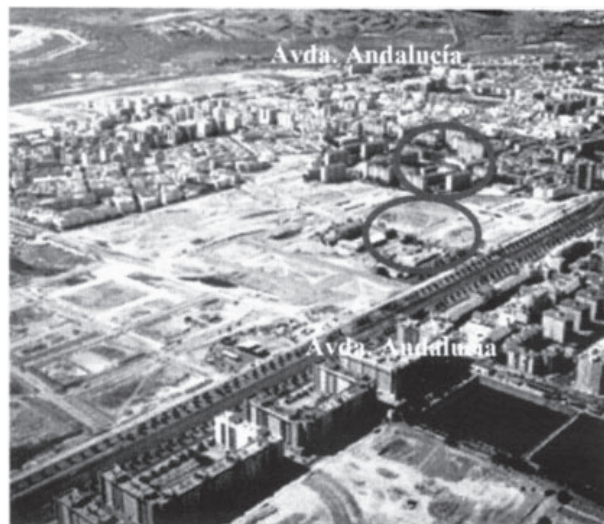
Vista Alegre y La Florida, estado de las obras en julio de 2002
