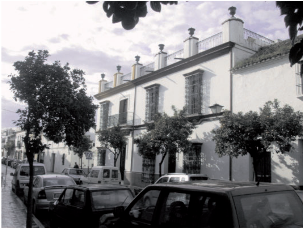
Fachada Principal de los dos inmuebles.
