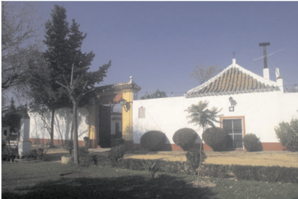
Acceso en fachada principal.
