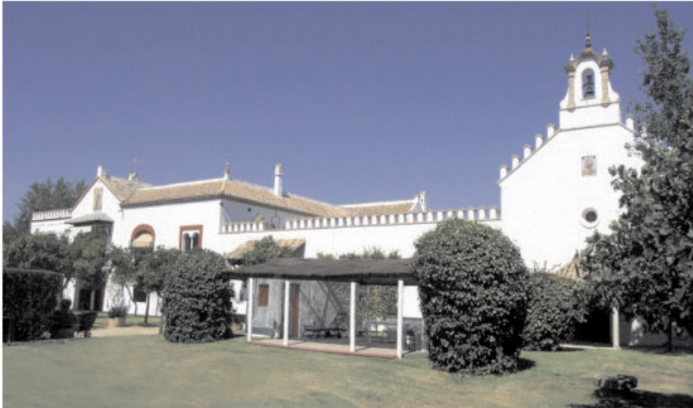
Fachada de la capilla.
