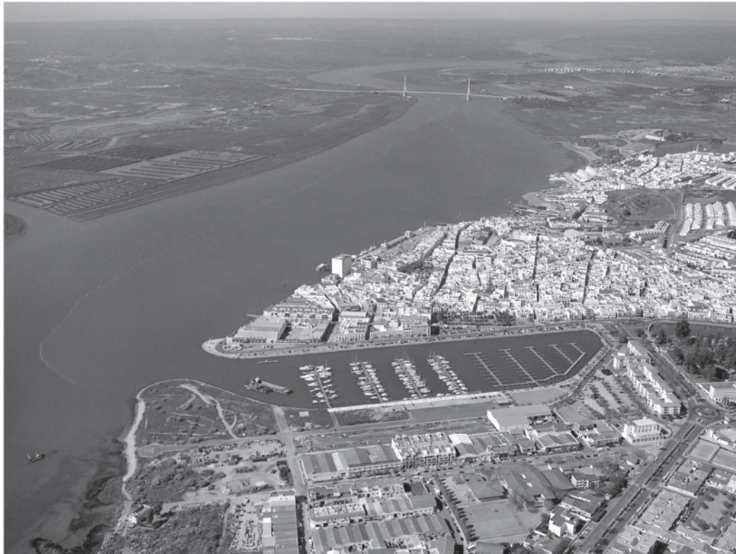
Puerto de Ayamonte. Vista hacia el Norte, al concluirse la ampliación de pantalanes en la dársena recreativa el año 2006.
