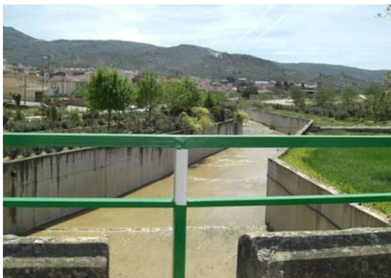
Encauzamiento del río Eliche (Los Villares)
