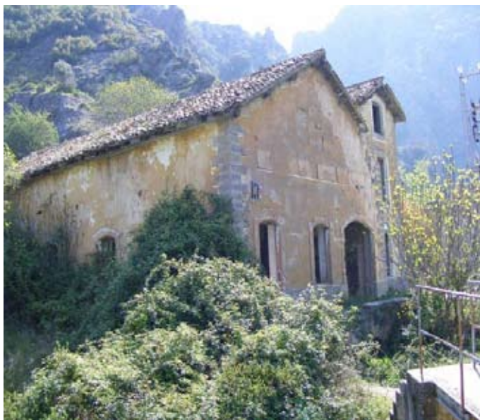
Central Hidroeléctrica de Valdepeñas de Jaén
