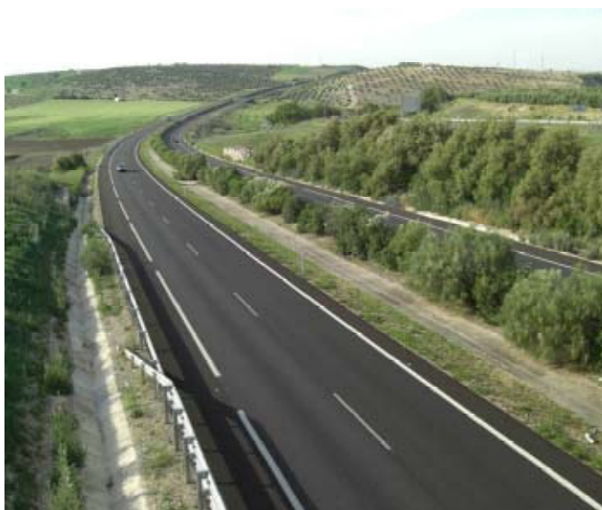
Autovía A-44 Bailén-Motril
