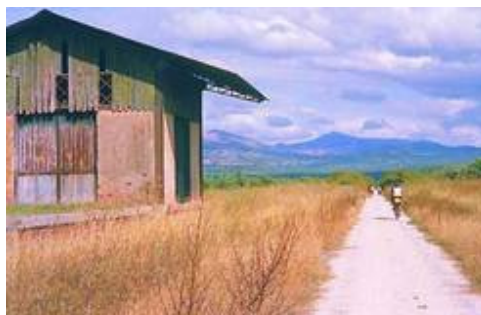
Estación de Vado Jaén y Vía verde del Olivar
