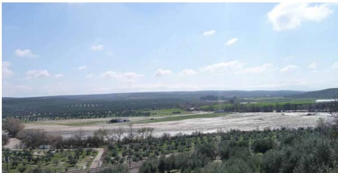
Inundación río Guadalbullón, tramo Las Infantas-Mengibar.
