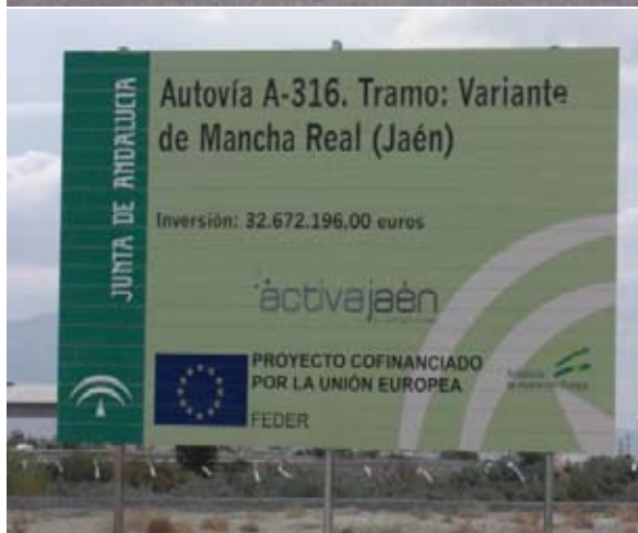
Acceso a Mancha Real desde la A-316 (en ejecución)
