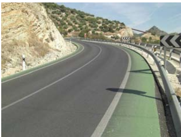
Carretera A-6050 (vía multimodal Jaén-Los Villares)
