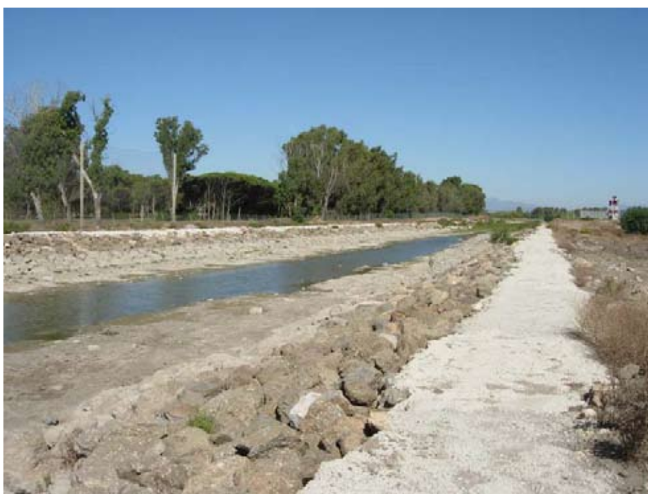
Fig.43. Foto del cauce
