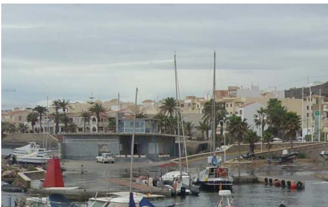
Vista del edificio administrativo y de aseos junto al acceso
