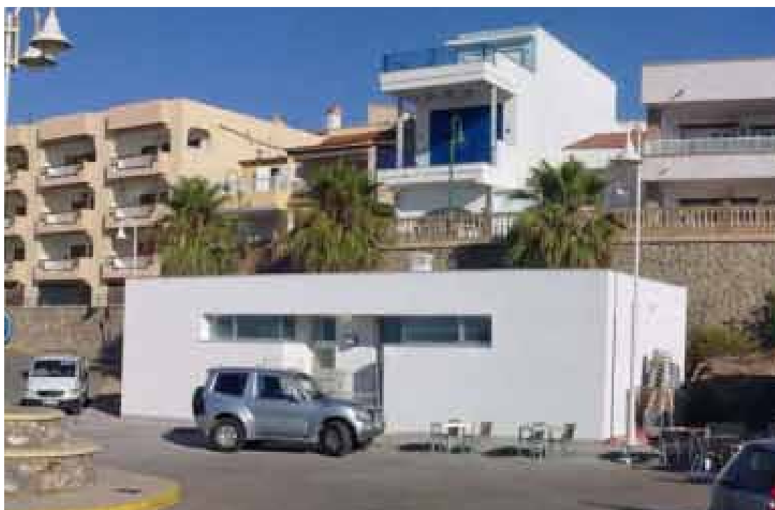
Edificio de duchas y aseos ejecutados en 2010
