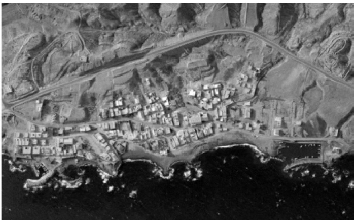
Instalaciones portuarias de Villaricos (1984)
