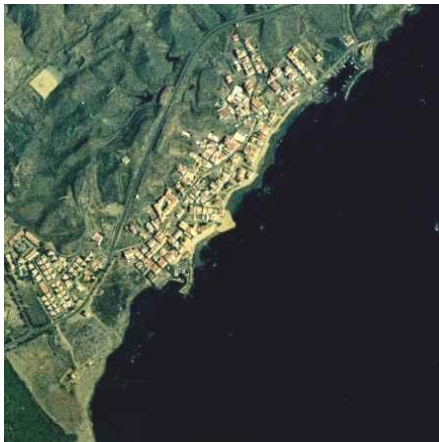
Instalaciones portuarias de Villaricos (1996)
