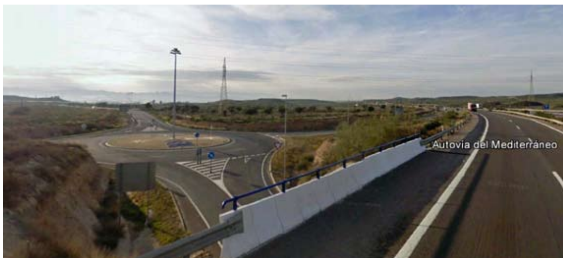
Intersección A-7 con AL-3108
