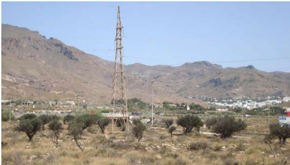
Intersección A-7 con AL-3108
