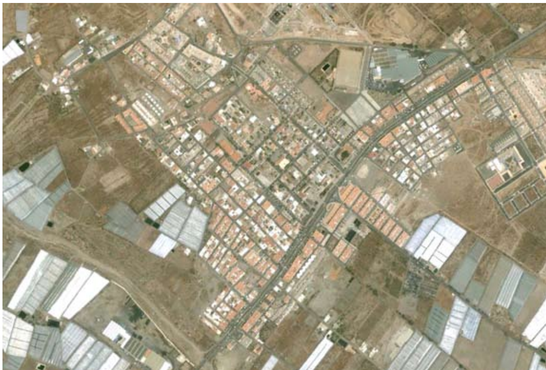
Gama cromática de las cubiertas en la zona, aconsejada para el tratamiento superficial de las edificaciones: blancos y grisáceos (invernaderos) o colores terrosos claros similares al territorio circundante (zonas urbanas)
