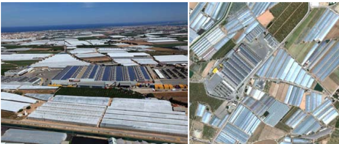
Integración de nave industrial con placas solares, invernaderos y campos de cultivo en Pilar de la Horadada (Murcia)
