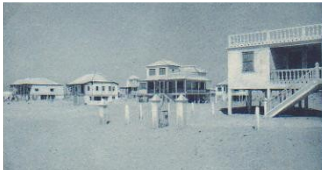
Edificios de la Río Tinto Limited Company
