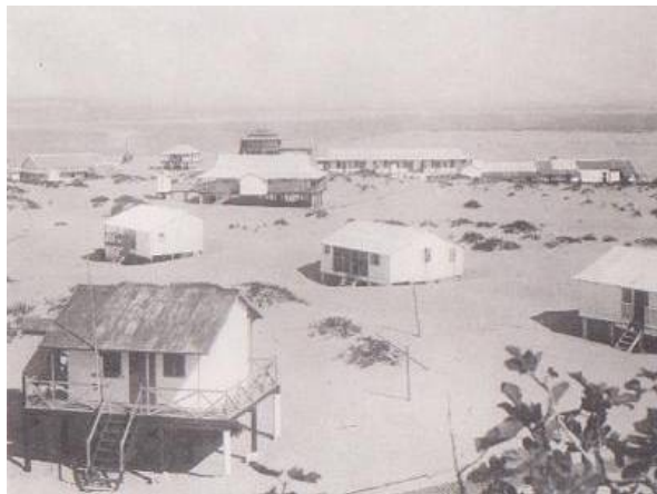
Edificios de la Río Tinto Limited Company
