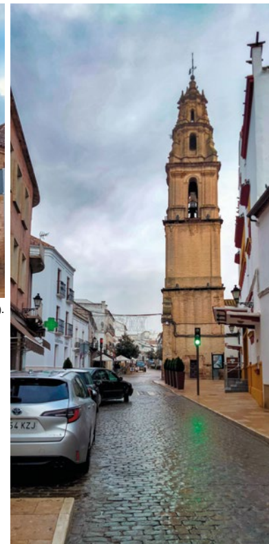
San Francisco de Asís Tower (Bujalance).
