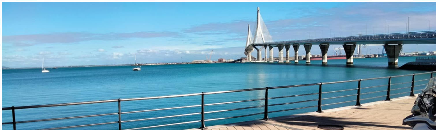
Constitución de 1812 bridge (Cádiz).
