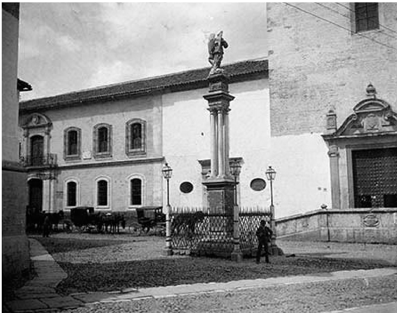
Antigua foto de la Plaza de la Compañía, en cuyos alrededores vivieron Beatriz Enríquez de Arana y Cristóbal Colón
