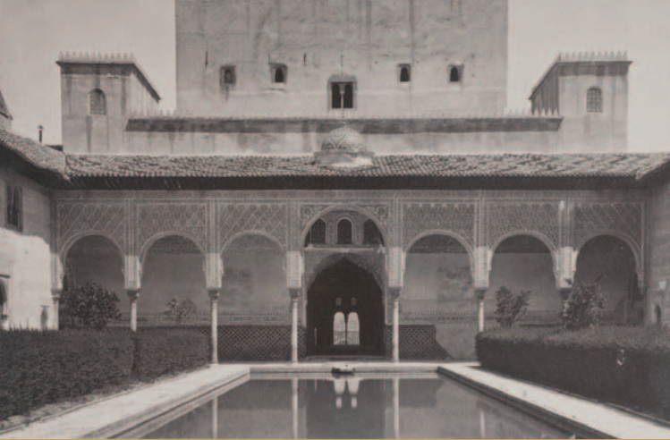
Exterior de la galería lateral izquierda del Patio de los Arrayanes (1871)
