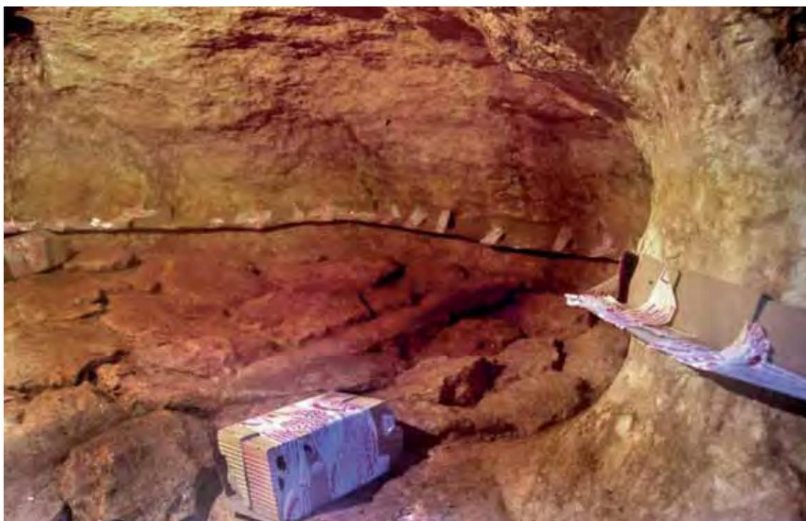
*Lámina 10.5. División en dos partes de la cueva; bóveda y suelo. Colocación de los soportes del tablazón.*
