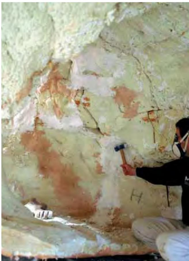
*Lámina 10.77. Interior de la bóveda. Eliminación de las uniones de yeso.*
