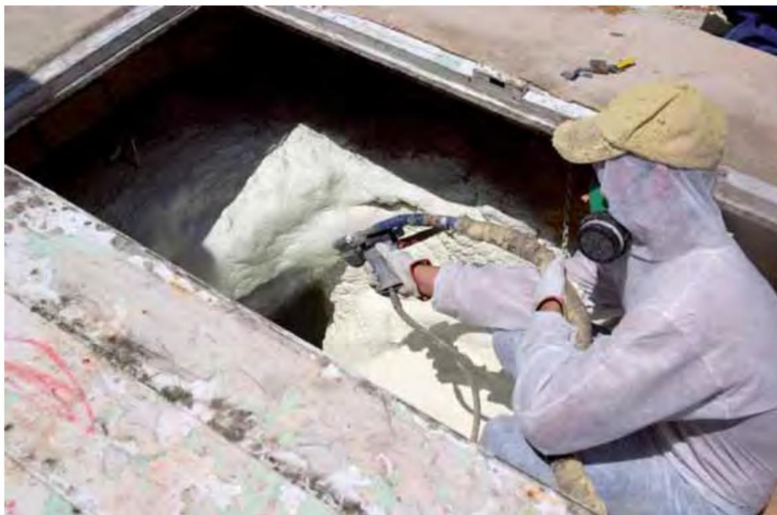
*Lámina 10.26. Superposición de estratos de espuma.*
