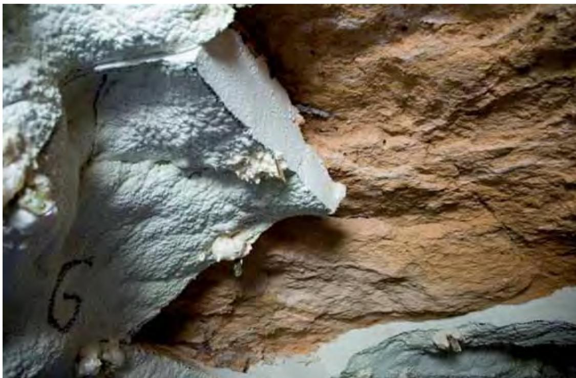
*Lámina 10.32. Separación de piezas en la parte del techo de la bóveda.*
