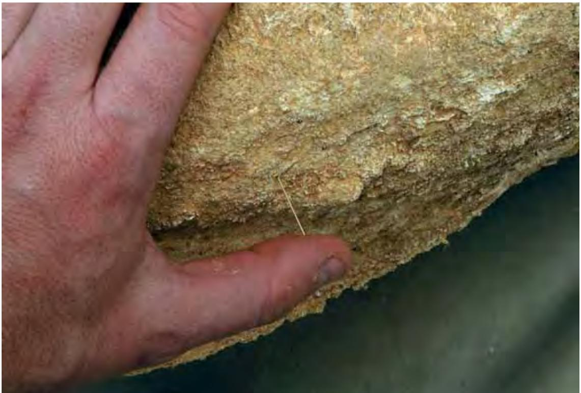
*Lámina 10.60. Detalle de la introducción de alfileres después de extraer las alcayatas.*
