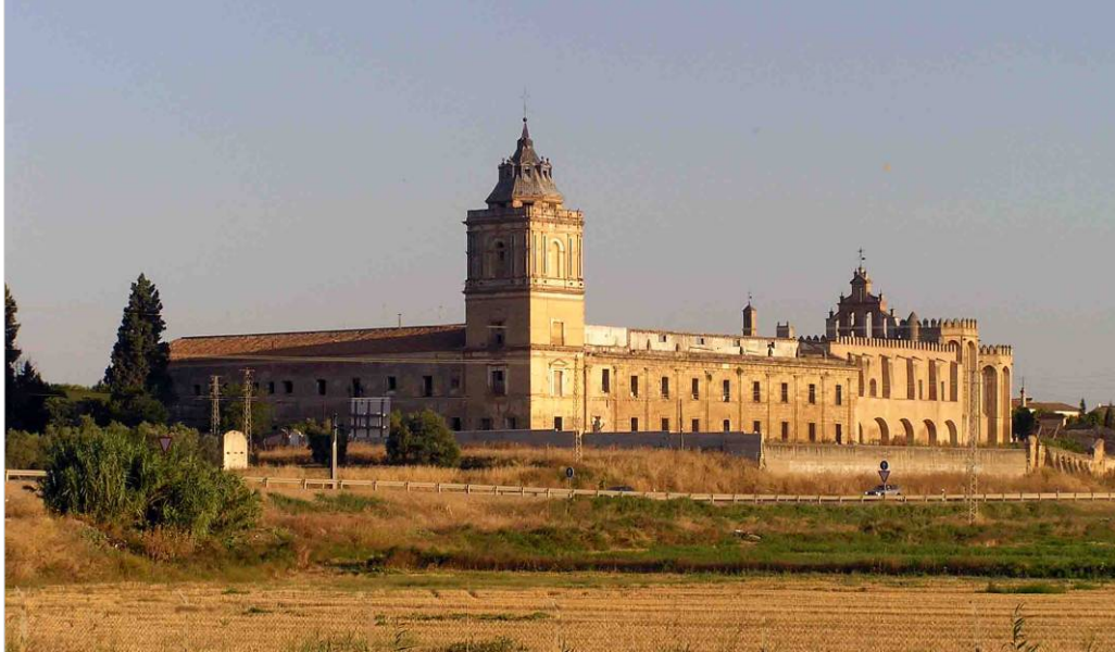
Torre barroca y edificio este del monasterio
