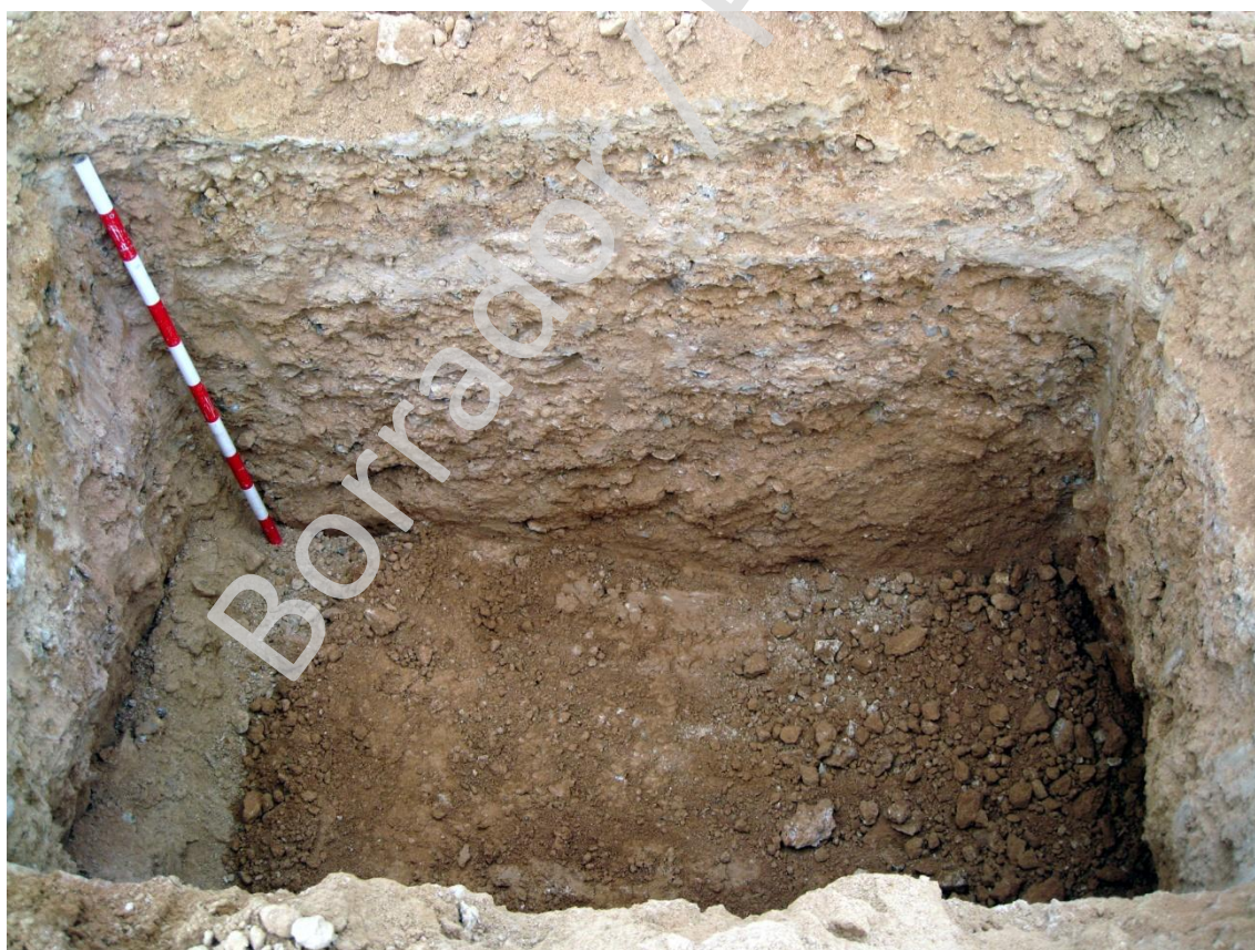
Ilustración 9: Sección de una zapata de cimentación.
