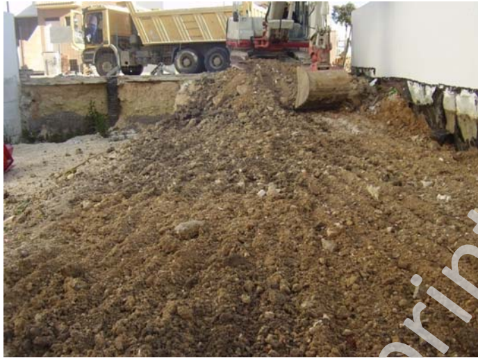
Lám. I: Excavación mecánica de la UE 1.
