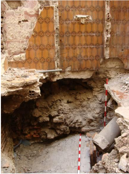
lám. g. trabajos de reposición de la bóveda y acondicionamiento del sector afectado en el interior de la vivienda.
