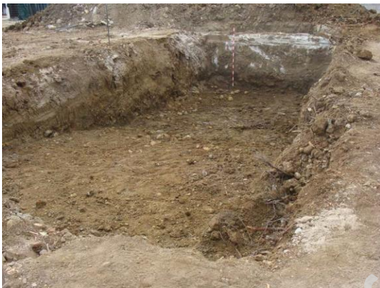
lám. h. Caras este y sur, en esta última apreciamos el alzado de hormigón de la antigua piscina.
