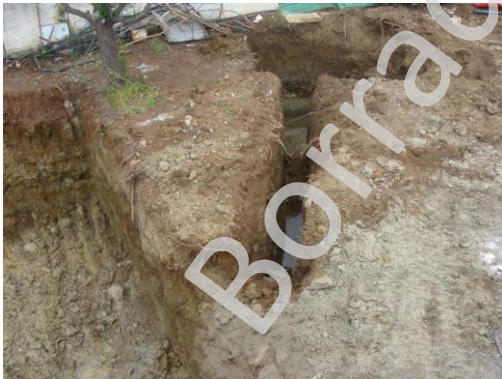
lám. f. Vista aérea del pozo y canalización, situados al sureste respecto al sótano.
