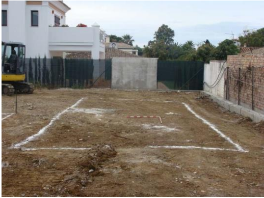
lám. g. Vista previa al inicio de los trabajos de rebaje de la piscina, localización desde septentrión.
