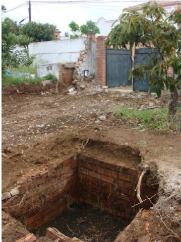
lám. d. Detalle del aljibe, desde el suroeste, localizado en el ámbito donde se ubicará el sótano.
