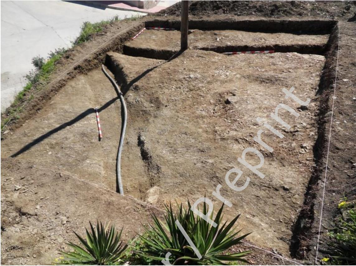
*Lam. 9. Afecciones en el geológico del corte 6 para la introducción de los tubos de fibrocemento*
