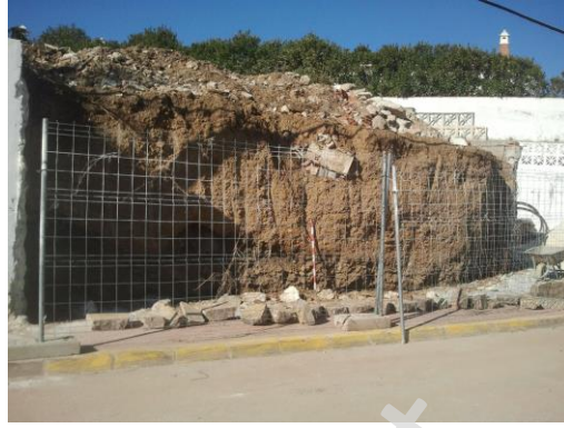
Fotografía 8. Final de los trabajos.
