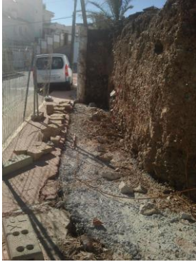
Fotografía 7. Final de los trabajos.
