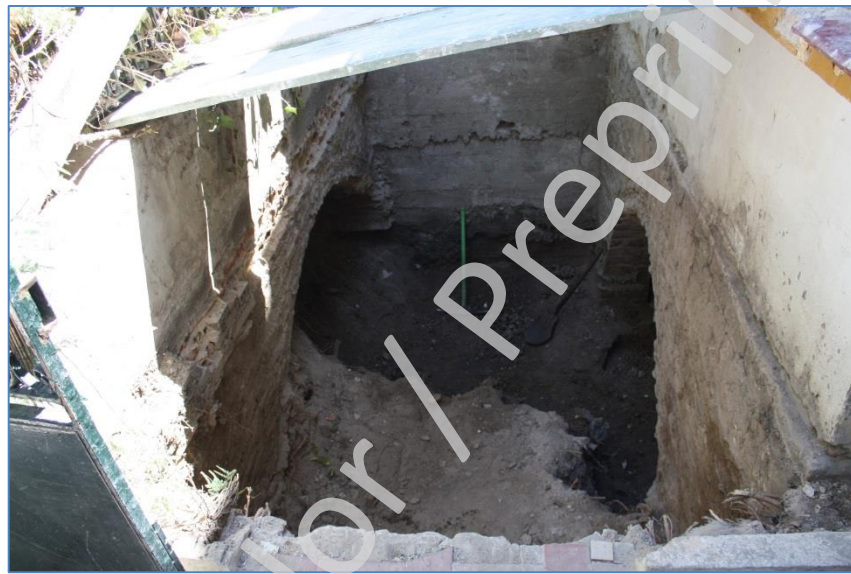
Lám. VII. Unidad de Intervención 3 durante el proceso de excavación
