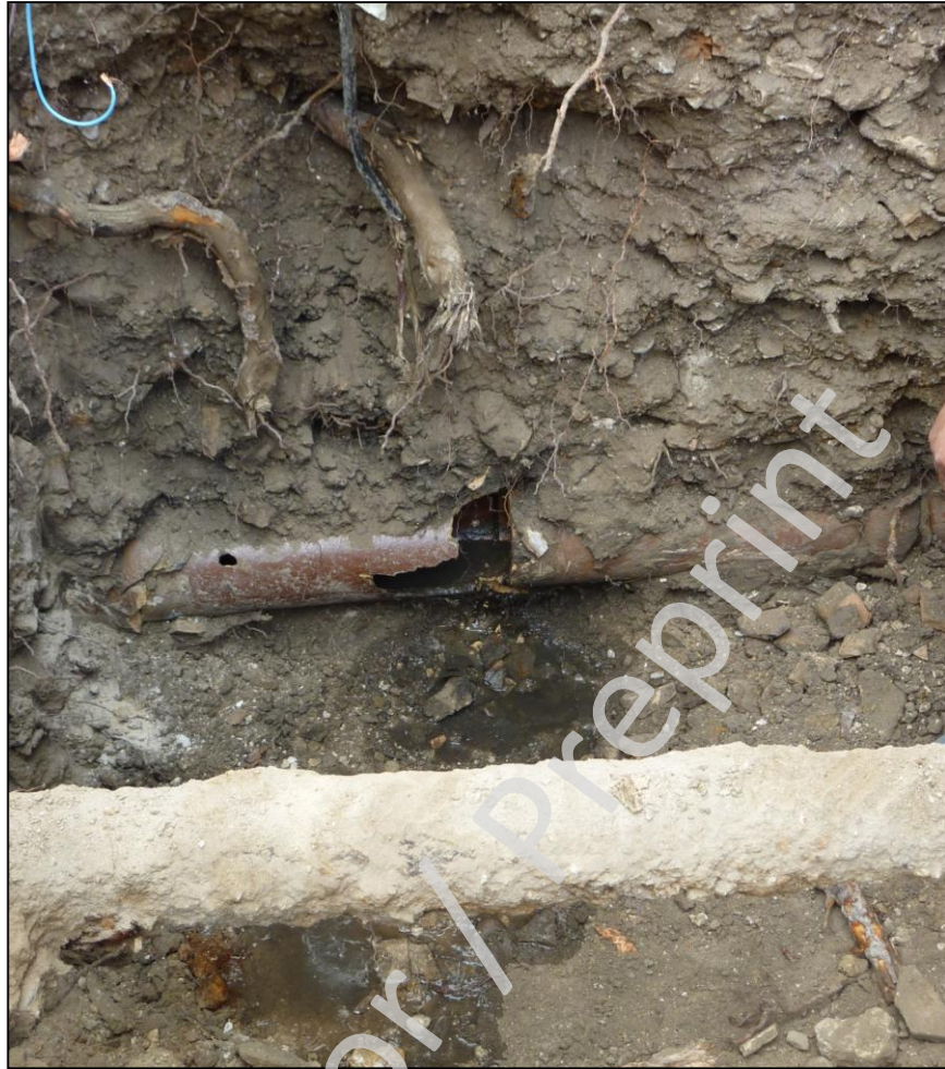
Tubería de hierro y otra de gres en el perfil, a 2 m de profundidad
