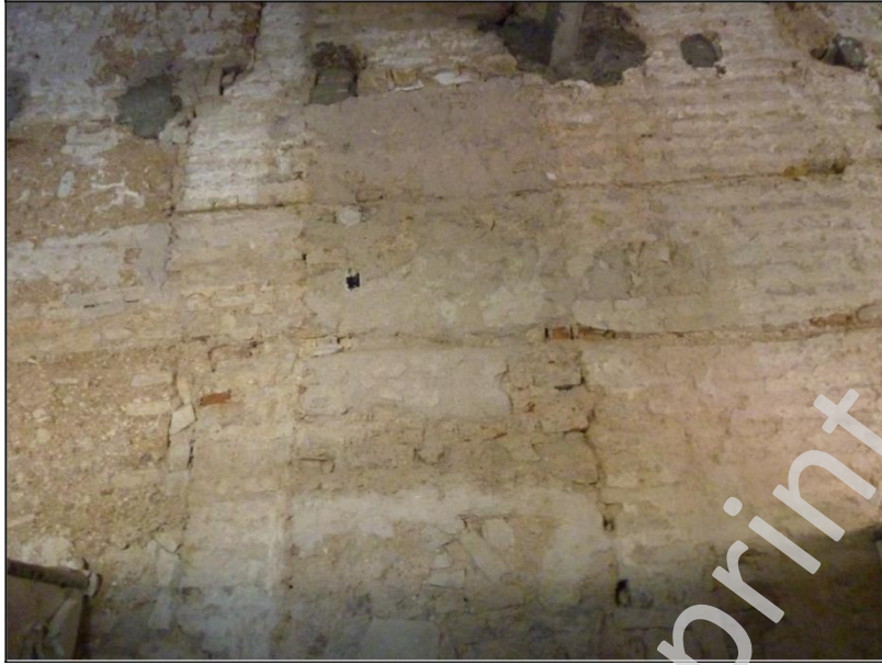
Fotos del muro tras retirar las capas de pintura y picarlo
