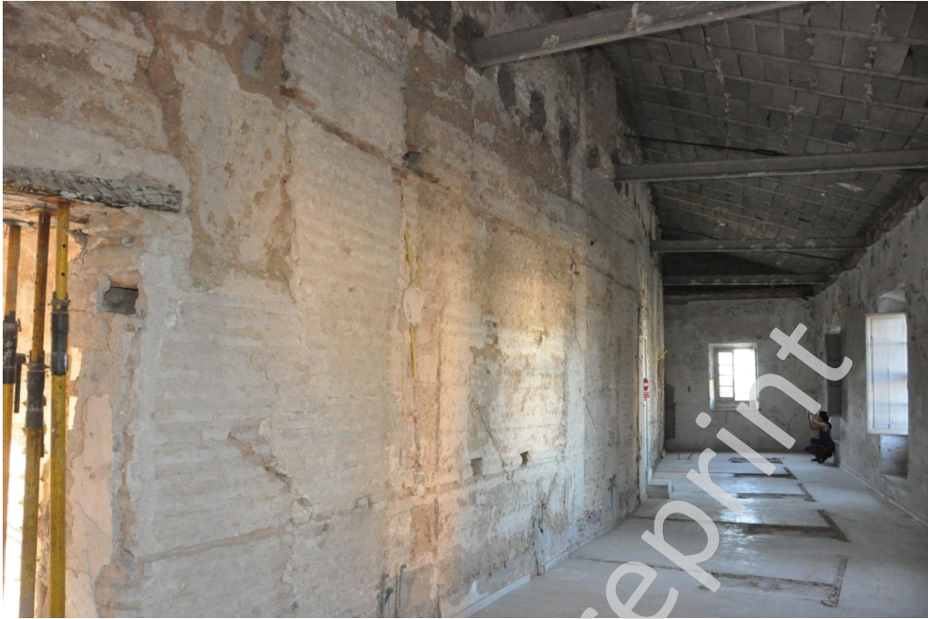
Giro o corte que realiza la fachada
