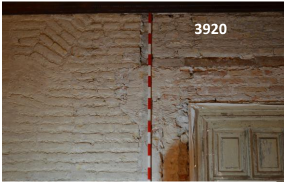
Lámina 21. Detalle del cegamiento de las celosías originales.
