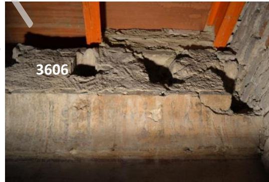
Lámina 25. Huellas de empotramientos pertenecientes al segundo momento de restitución de sus cubiertas (circa 1596).
