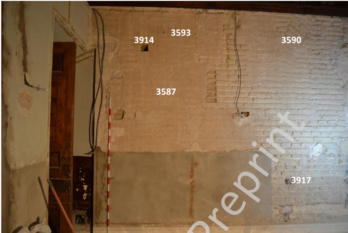
Lámina. 13. Vista general del paramento objeto de estudio por su lado este
