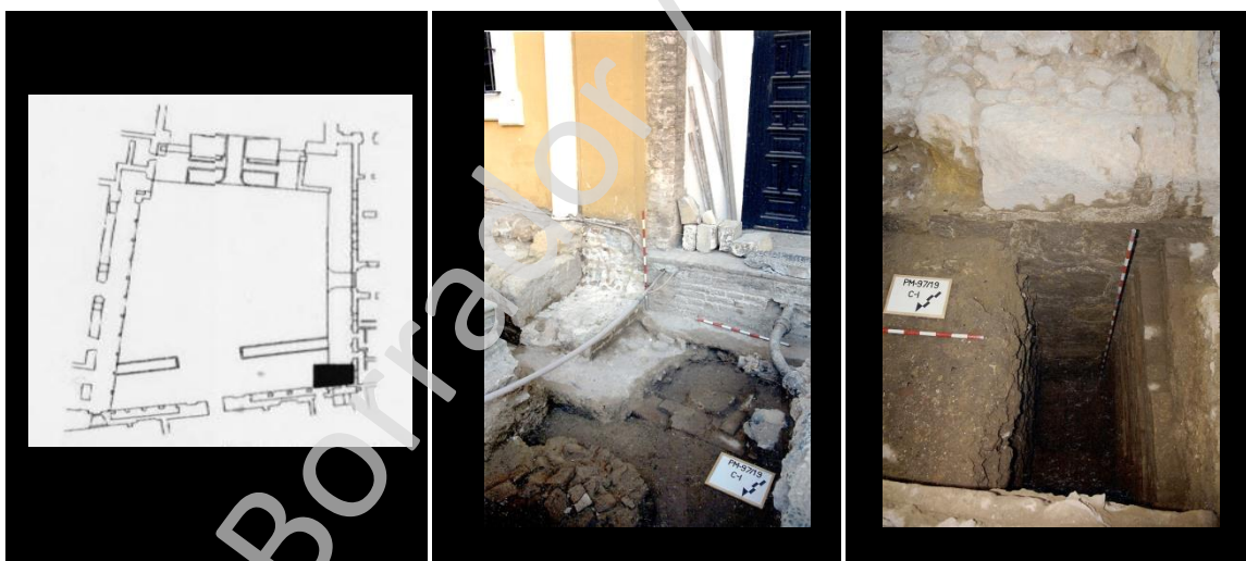
Lámina 2. Localización del corte I practicado en el sector sureste del Patio de la Montería (Tabales, 1997). En la imagen central podemos observar el juego de adosamientos al que es sometida la torre de sillares abbadí, con la superposición de un paramento alfonsí sobre el que se le adosa a su vez el cimientó de la fachada del Palacio del Rey Don Pedro. A la derecha, detalle del alzado de la torre.
