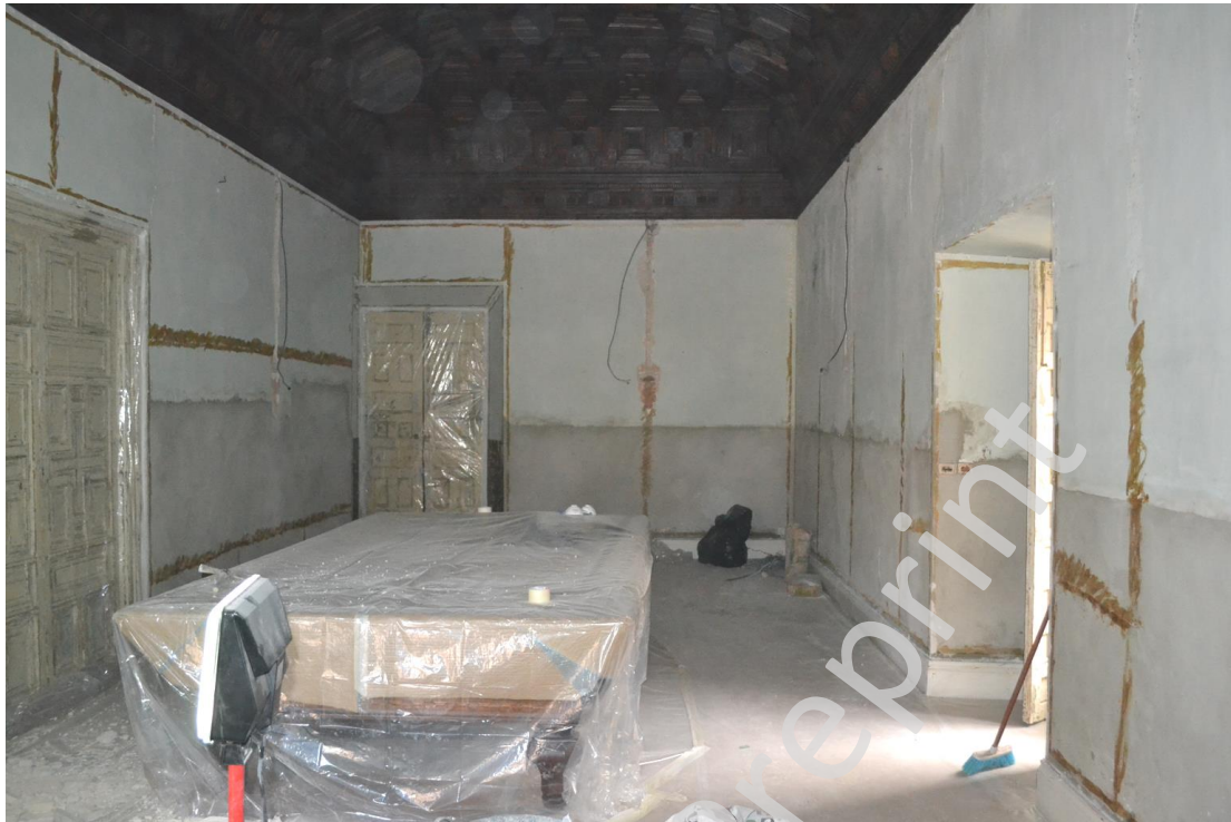
Lámina 12. Vista general de la Sala de Billar justo antes de iniciar el picado de su muro Sur.
