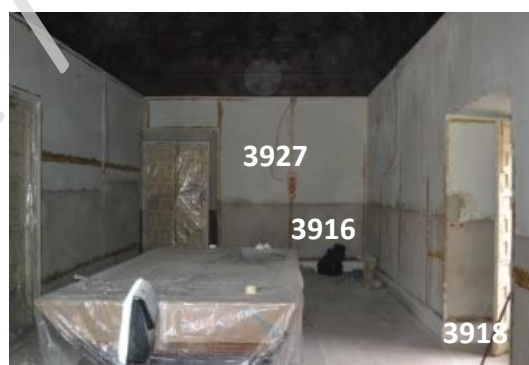
Lámina 28. Enlucidos y acabados relativos a la última fase correspondiente a reparaciones de época contemporánea.
