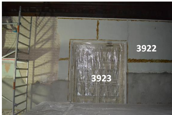
Lámina 21. Detalle del cegamiento de las celosías originales.
