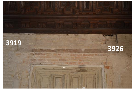
Lámina 16. Ubicación relativa a las tres celosías o ventanucos que decoraban originalmente el palacio mudéjar. Fueron eliminadas en tiempos de los RRCC, conservándose parcialmente en su lateral este.
