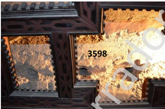
Lámina 24. Huellas de empotramientos pertenecientes al primer cambio de cubiertas adscribible a la etapa de los RR.CC
