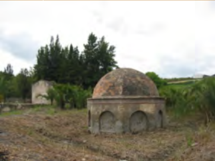
Foto 4.14. El Fontanal. En primer plano, fuente construida durante la primera mitad del siglo XVIII. Al fondo, alcubilla mudéjar.
