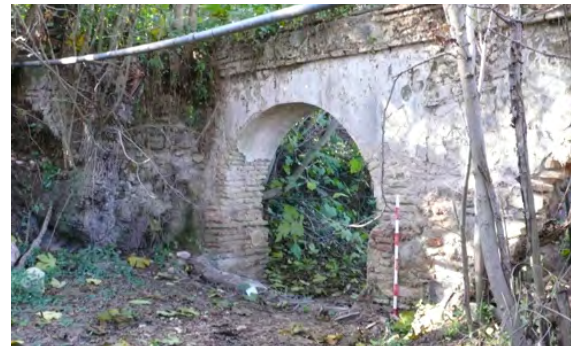
Foto 2.8. Acueducto del complejo hidráulico del Cortijo de Arriba.
