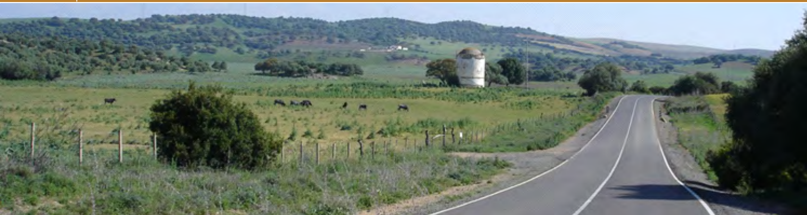
Carretera SE-6201 a la altura de cortijo Las Navas y Mojón Blanco.
