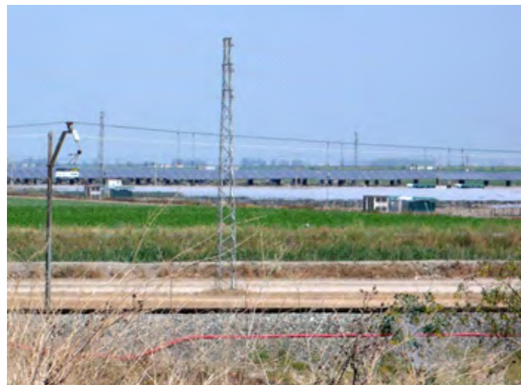
Foto 6.3. Parque Solar Fotovoltaico Solarpack instalado en la Marisma.
