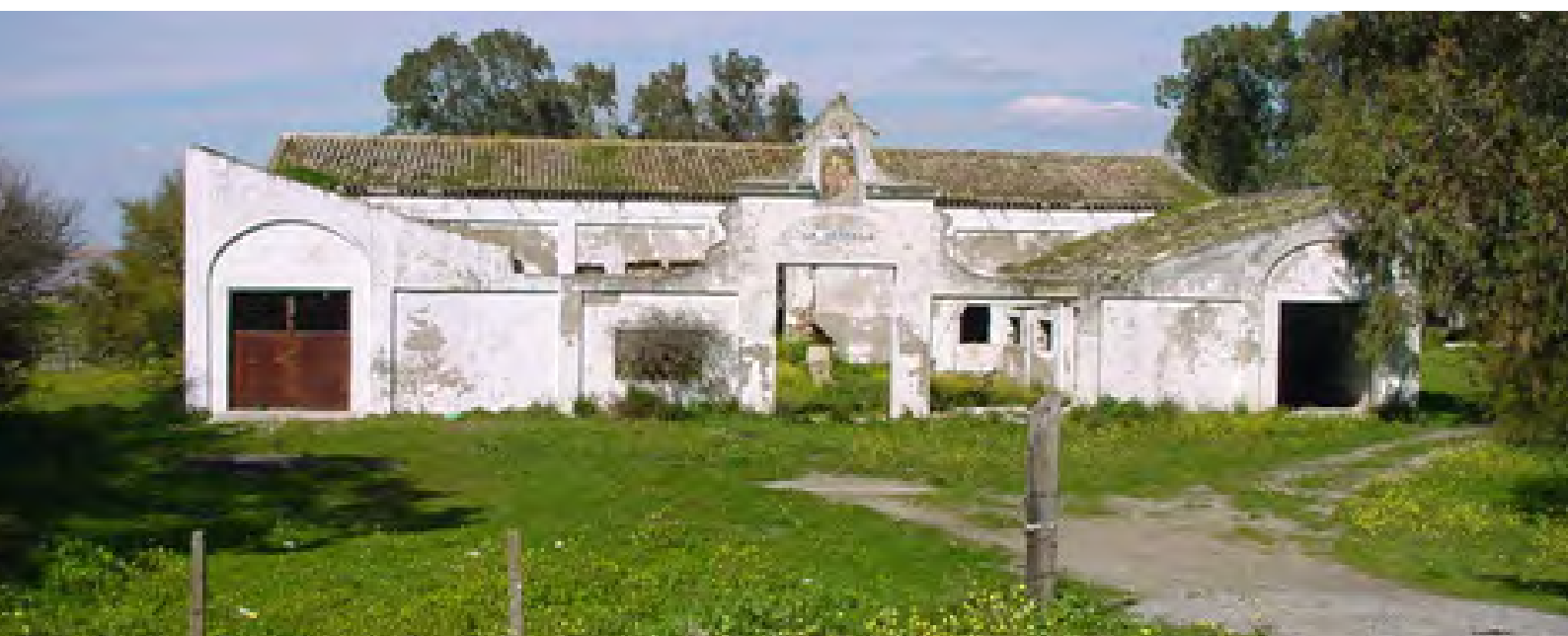
Foto 2.3. Finca La Señuela, del poblado de colonización del mismo nombre (siglo XX). Arquitectura incluida en el Catálogo del Avance del PGOU de 2009.
