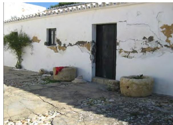
Foto 2.6. Elementos de carácter arqueológico ubicados en el patio del Cortijo La Campiña.
