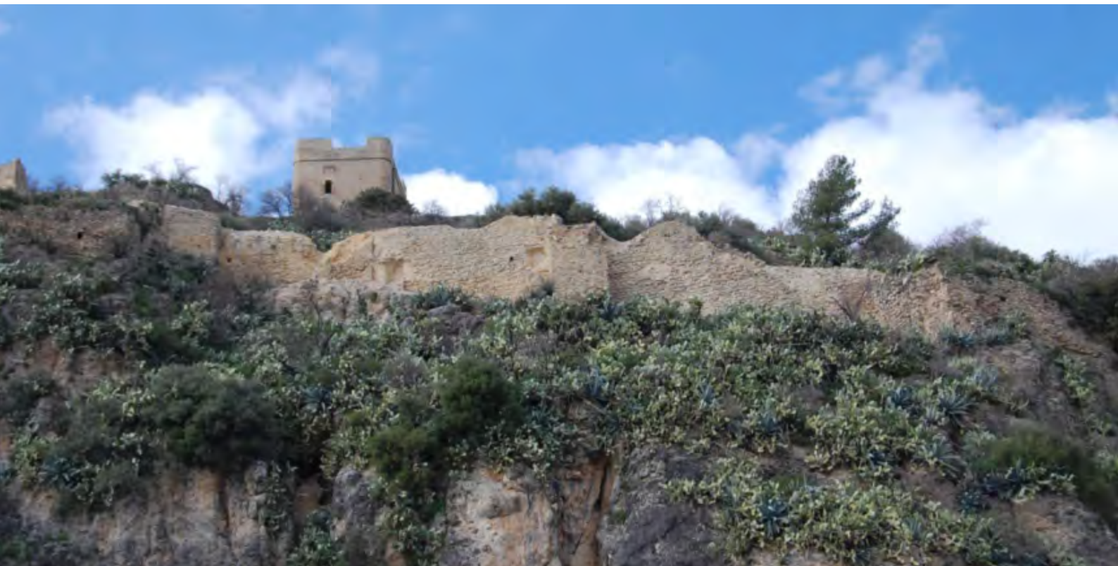
Muralla este. Tramos B y C.
