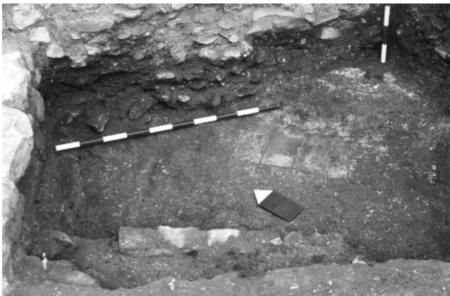
LÁM. IV. Cata II. Pavimento desmantelado y andén.
