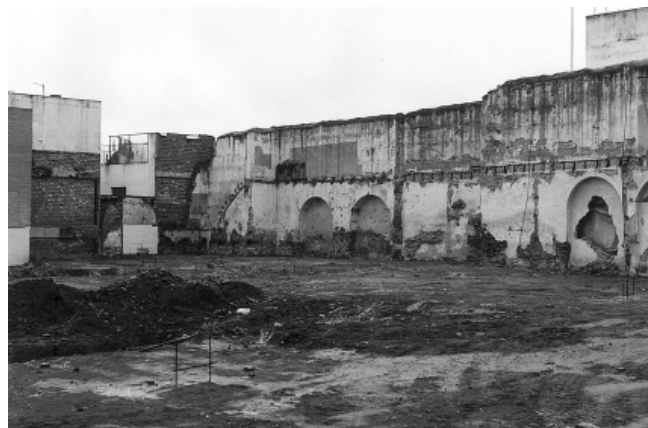
LÁM. III: Vista del lado Sur del solar, las paredes conservan los arcos de medio punto del edificio anterior -almacenes-.
