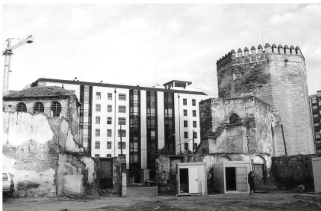
LÁM. II: Vista desde el solar de una de las entradas, situada en el lado Oeste. A la izquierda se ve la parte superior de un edificio que data del siglo XVII y a la derecha la Torre de la Malmuerta del siglo XV.
