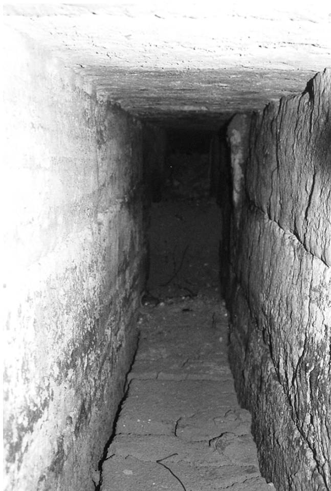
LÁM. VIII. Segundo tramo de la cloaca.
