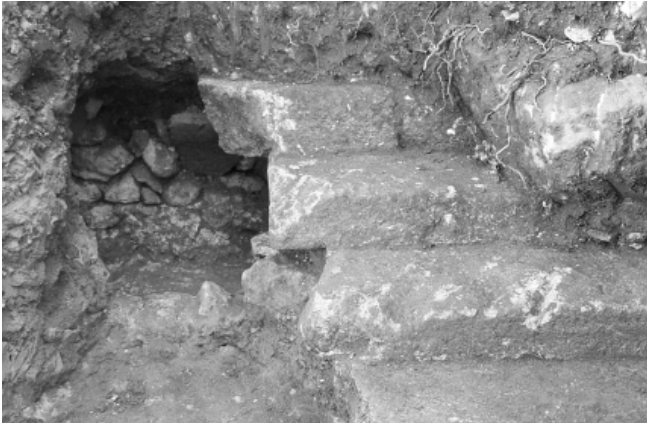
LÁM. VII. Escalinata de acceso a la terraza intermedia y ramal de cloaca.
