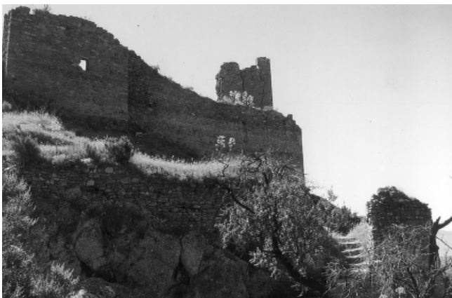
LÁM. I. Zona de entrada al castillo de Lanjarón.
