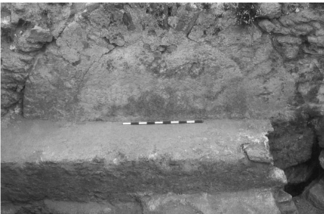
LÁM: X. Murete del "almacén" adosado al frente E del aljibe.
