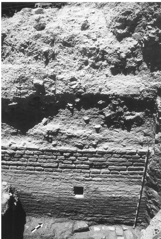
LÁM. I. Cuadrante B. Sondeo I. Detalle constructivo de la barbacana de Cano y Cueto.
