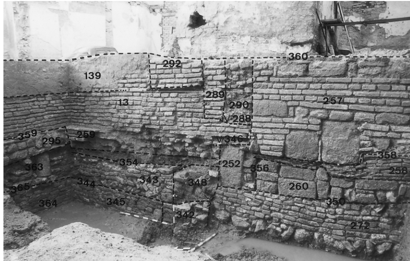
LÁM.VI. Paramento principal con indicación de superposiciones, vanos e interfaces. Fases constructivas de la II a la XII.
