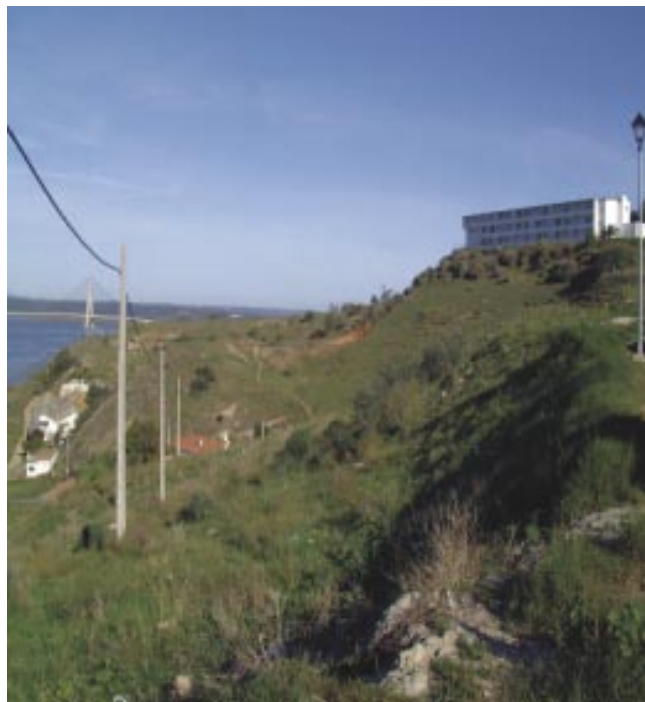
FIG. 2. Vistas de la zona de actuación
