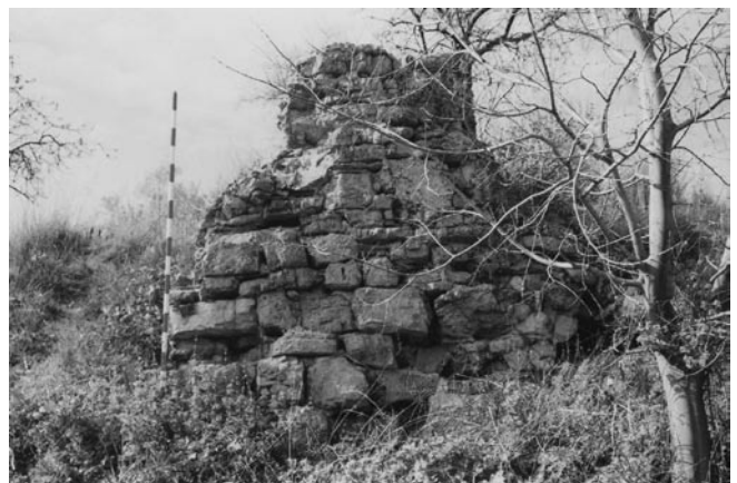
LAM. IV. Muro en la ladera este.
