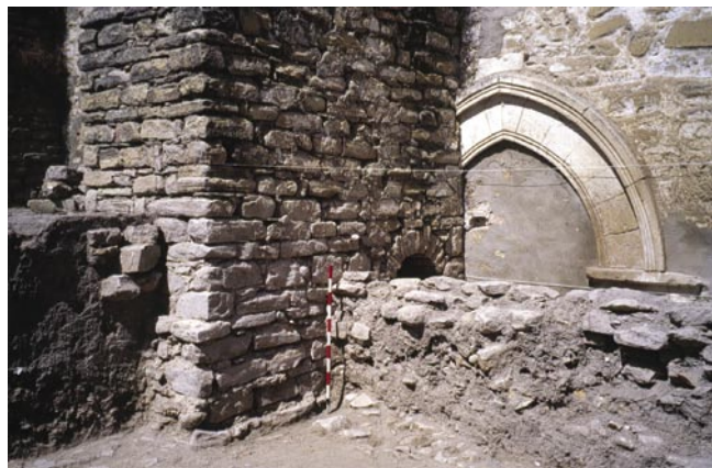
LÁM. IX. Huertos de San Benito. Terraza alta (área 3). Corte 3. Puerta gótica cegada por un contrafuerte con tronera en su base. Murete para proteger el canal de desagüe a lo largo de la pared de la iglesia de las tierras erosivas.
