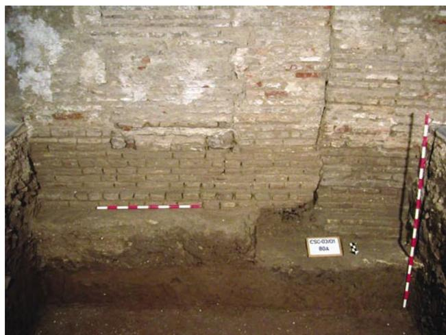
FIG. 8. Perfil meridional del corte 80A en el que se observan los dos muros, unidad 44 a la izquierda y unidad 442 a la derecha, que forman el actual cierre meridional de la nave de los dormitorios, así como sus zapatas correspondientes (u.e. 588 y 613). Igualmente es de destacar la claridad con la que se identifica el corte horizontal sobre el relleno más bajo de color rojizo (u.e. 590) que representa la profundidad de las zanjas de cimentación de ambos muros.
