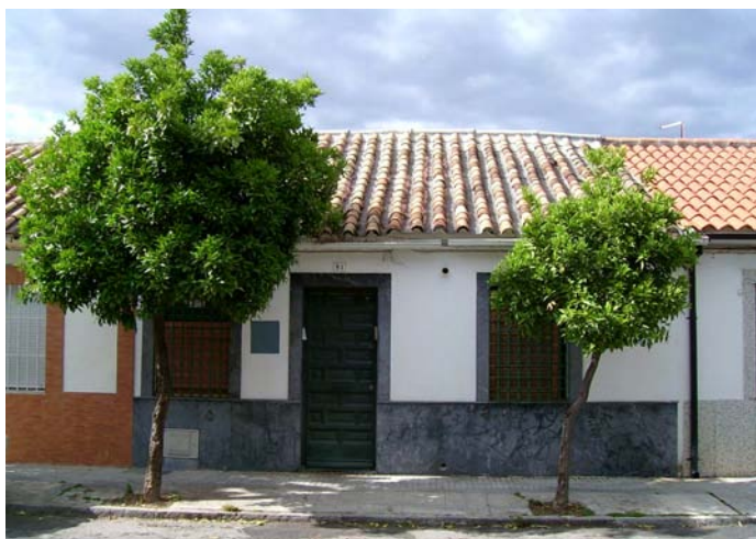
Lámina I. Vivienda demolida antes del inicio de la intervención.
