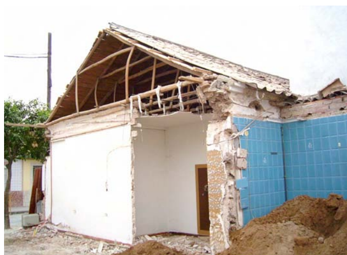
Lámina II. Vista del sistema de cubierta de las antiguas viviendas de Cañero.
