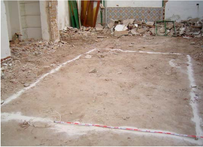
Lámina IV. Planteamiento del corte antes de la intervención.
