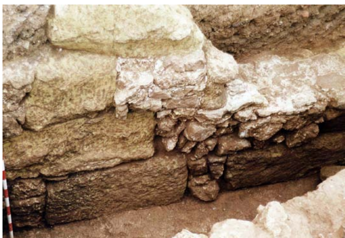
Lámina III.- Técnicas constructivas: empleo de la sillería de calcarenita, alternando con mampostería irregular trabada con mortero de cal y arena (U.E. 52 del Corte 1).
