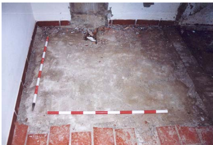
Lámina I. Situación del Sondeo UE 2. Pavimento de hormigón.
