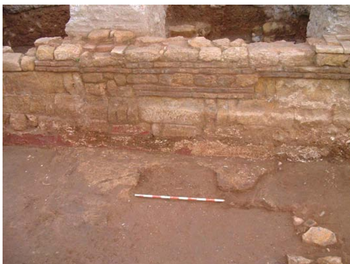
Lámina IV. Sondeo 2. Paramento U.E. 139 con el nivel de suelo terrizo conservado U.E. 140. A la derecha, cimentación U.E. 145 de tabique de compartimentación del espacio doméstico.
