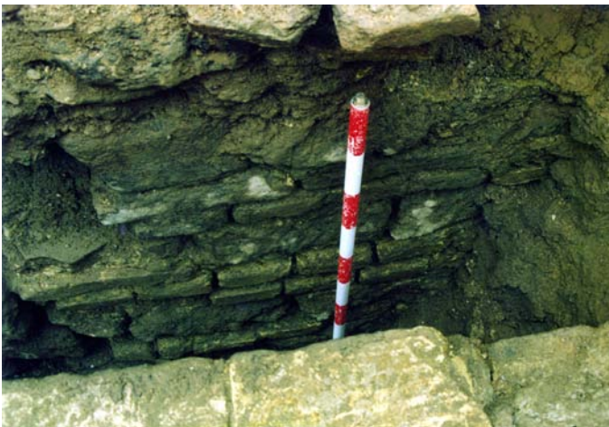
Lámina IV. Corte 2. Aparejo del muro oeste del pozo de noria (U. E. 5)
