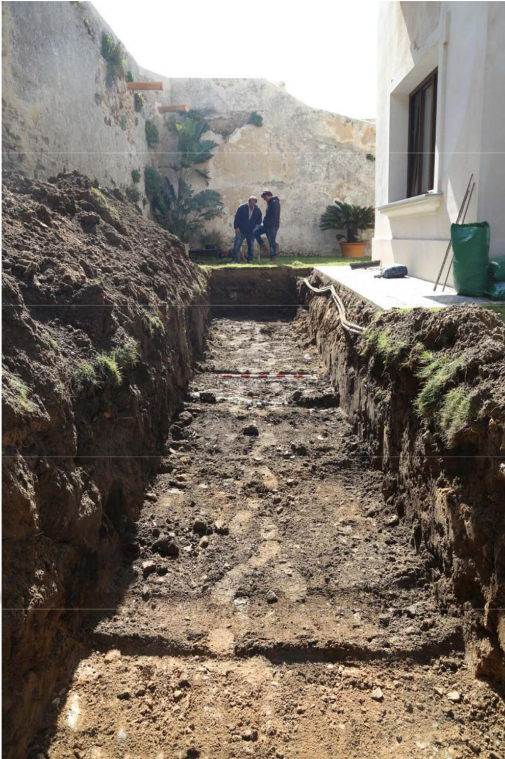
Resultado una vez realizados los trabajos
