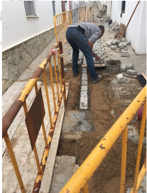
Lám. XXXIV a XXXVII.- Diferentes fases de ejecución de la zanja de acometida eléctrica.
