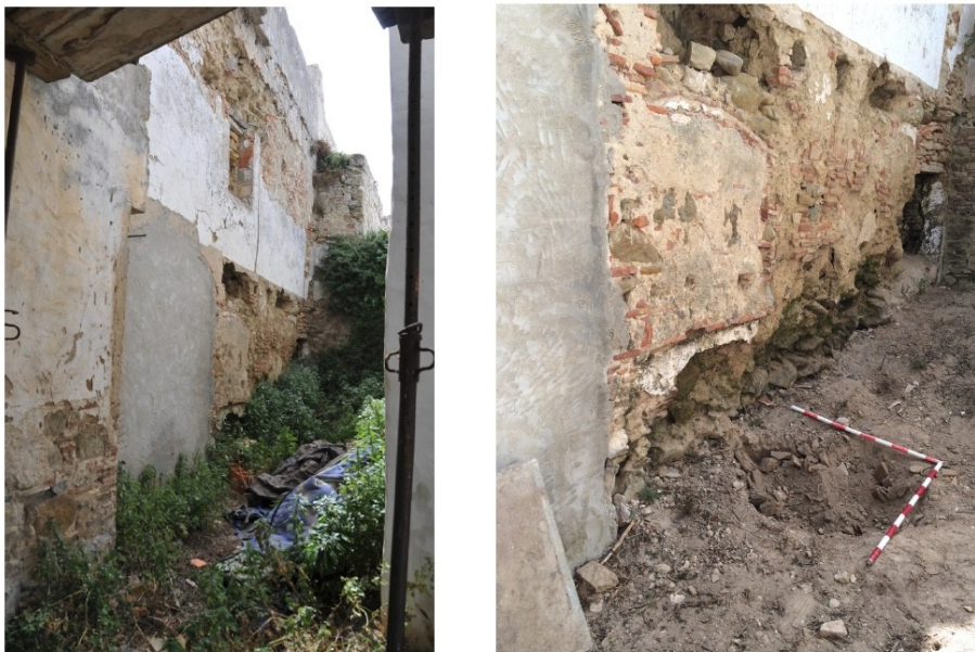
Lám. XXV.- Estado inicial del lienzo interior de la muralla.
