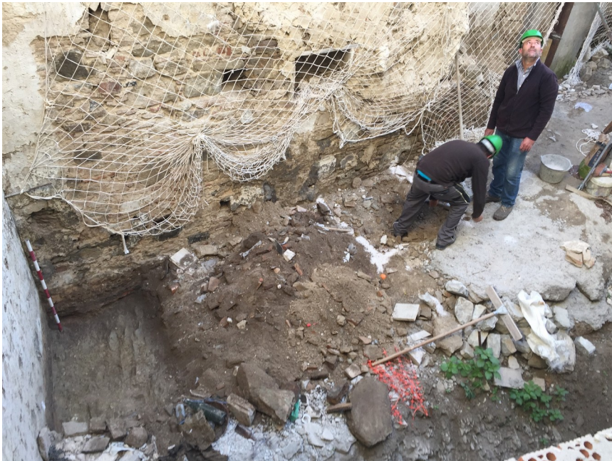
Lám. V. Sondeo 2. Estado inicial (a la izquierda el sondeo 1).
