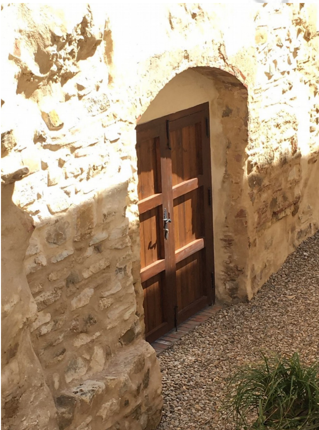
Lám. XXXI y XXXII.- Sustitución de la puerta de madera que cerraba un vano de la muralla (vista interior).
