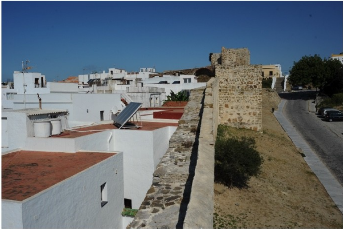
Lám. XXIV.- Adarve desde la torre adyacente al lienzo de muralla objeto de estudio hacia el sur, con un camino de ronda y parapetos fruto de restauración reciente; puede apreciarse la nítida diferencia de espesor con la muralla que transcurre por el solar (derecha) reducida a una exigua tapia.
