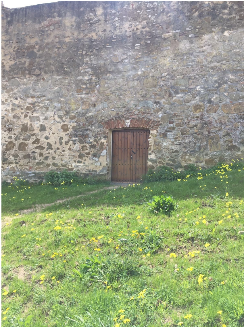
Lám. XXXIII.- Sustitución de la puerta de madera que cerraba un vano de la muralla (vista exterior).
