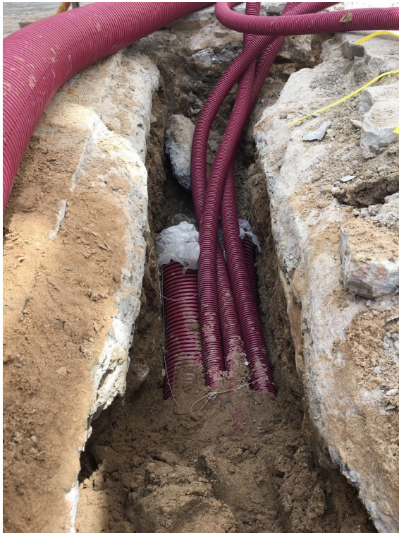
Lám. XXXIV a XXXVII.- Diferentes fases de ejecución de la zanja de acometida eléctrica.
