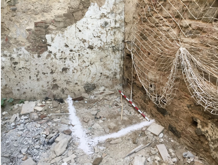
Lám. I. Sondeo 1. Delimitación y estado inicial.
