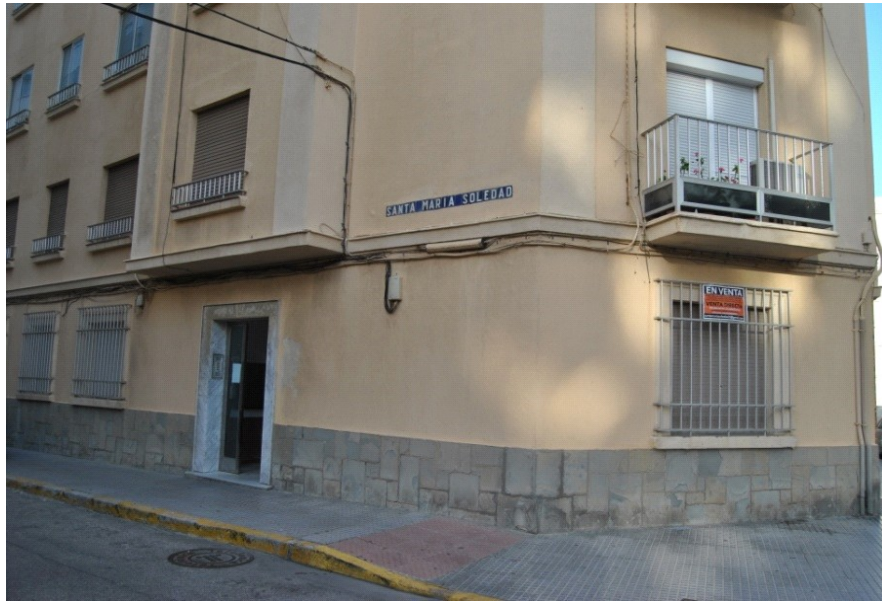
Imagen I. Detalle de la Fachada de la Vivienda.
