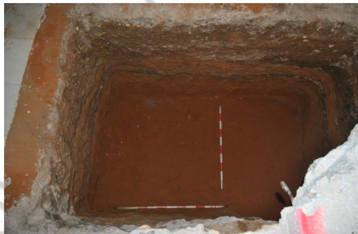
Imagen X: Vista General de la Finalización del Foso de Ascensor.
