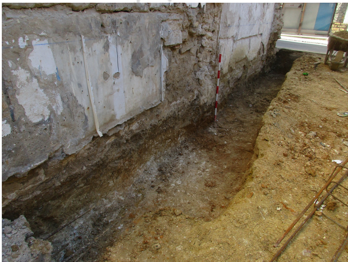
LÁMINA I. Zanjas de cimentación, en la medianera Norte
