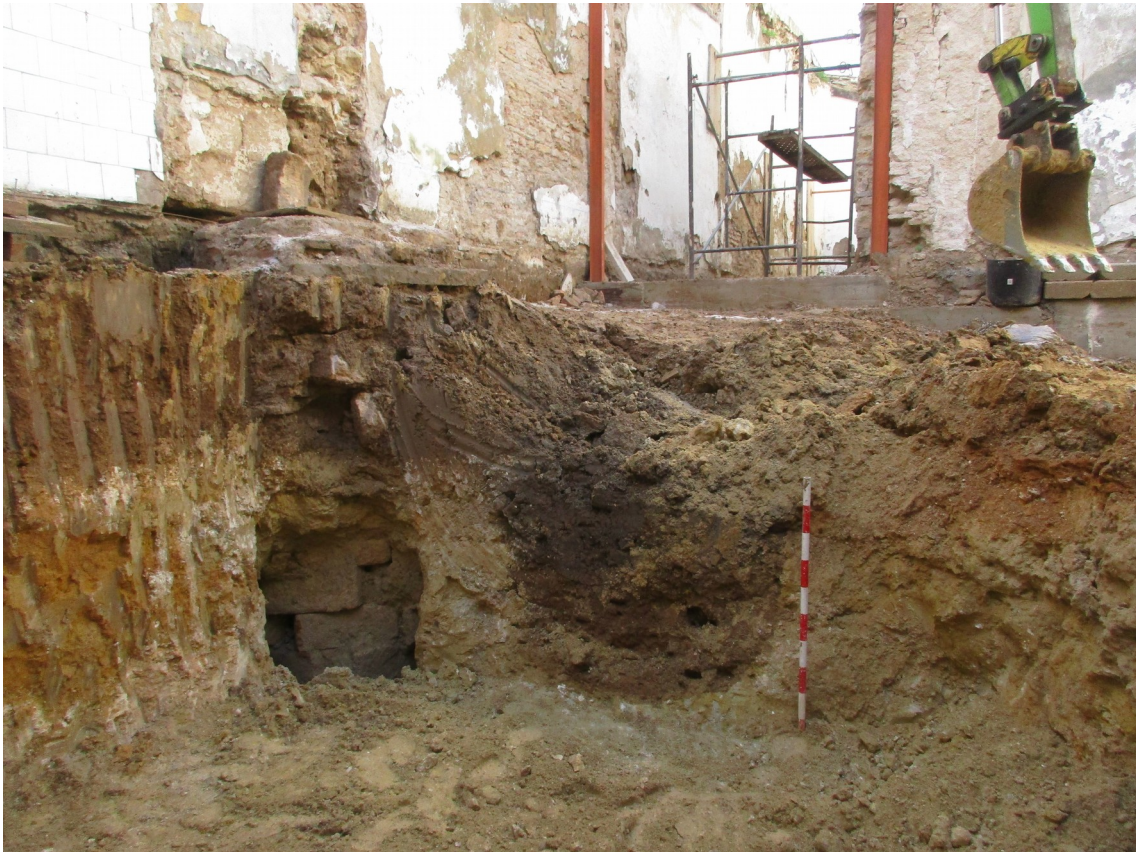
LÁMINA V. A la izquierda Pozo UE 11, tras aparecer la oquedad.
