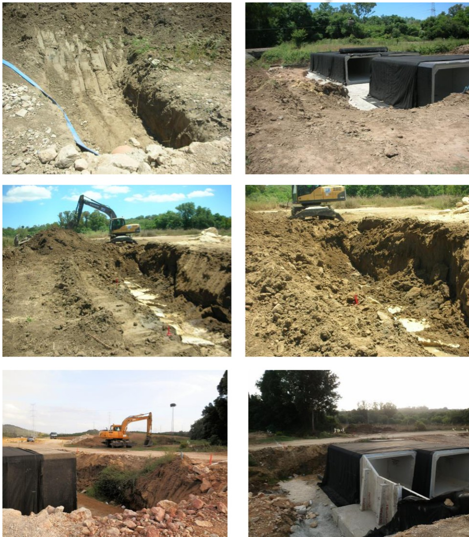
Vista general de los trabajos efectuados
