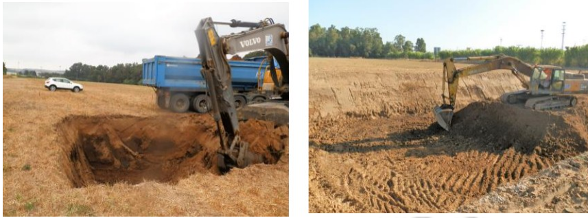
Vista general de los trabajos efectuados
