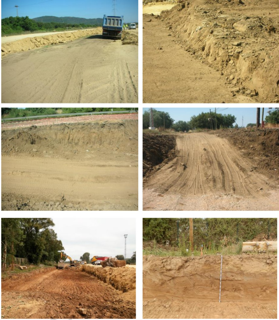
Excavación en la traza
