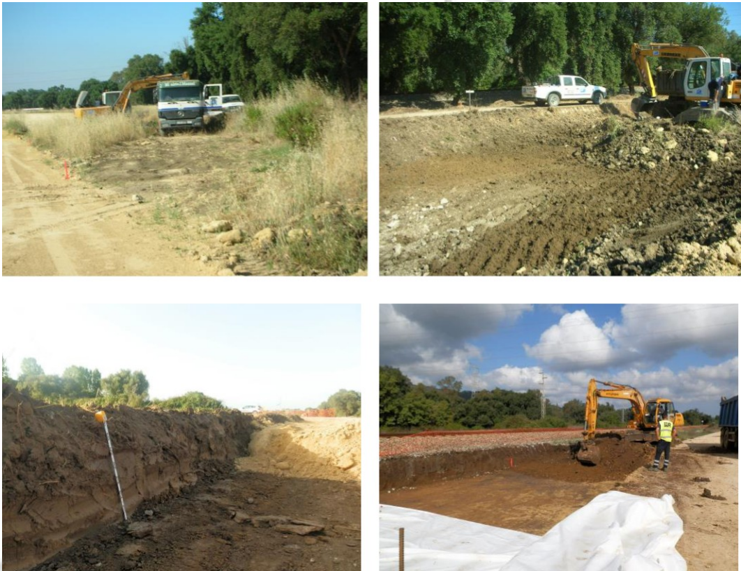
Vista general de la zona y los trabajos efectuados
