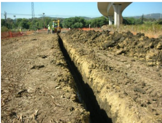
Apertura de zanjas para ubicación de servicios
