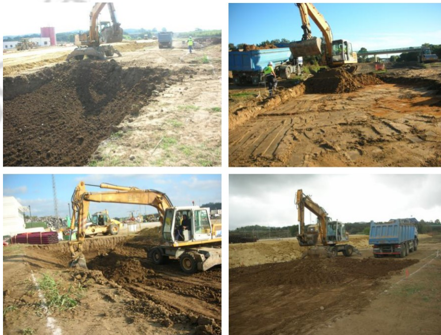
Proceso de excavación de la traza en la zona
