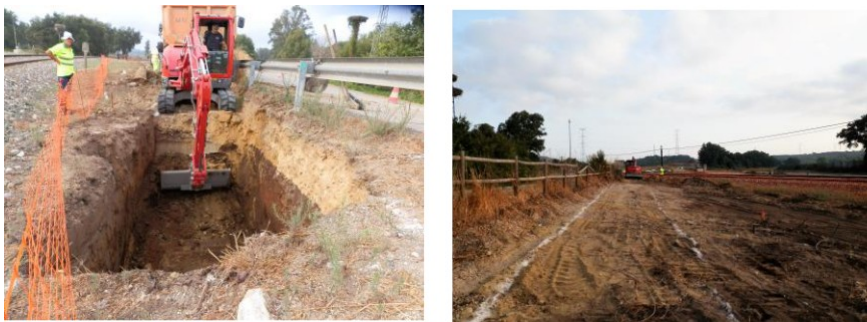
Excavación del muro de contención en el entorno del PK 4+740
