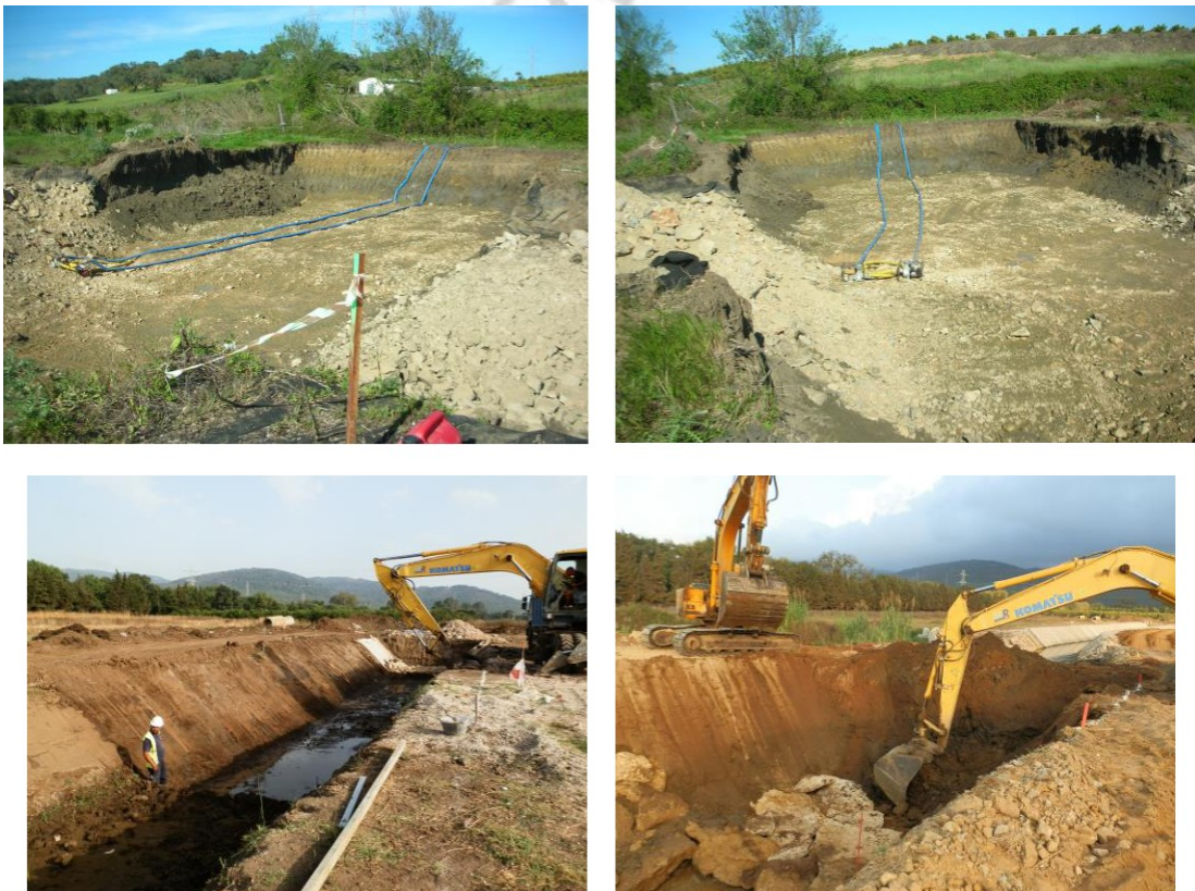
Vista general de los trabajos efectuados
